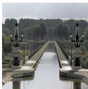
Pont-canal de Briare
