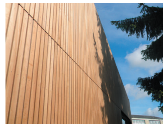
Bardage bois en peuplier d'une école à Nogent sur Oise, réalisé par «Bois durable de Picardie», une scierie aidée par le Conseil régional.
