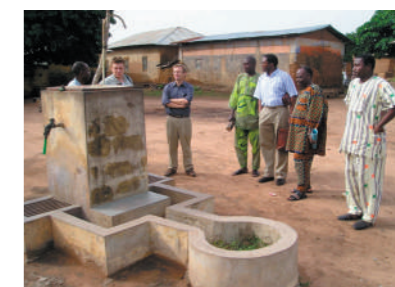
Une adduction d'eau potable financée par le FDL sur le territoire des Collines - Bénin
