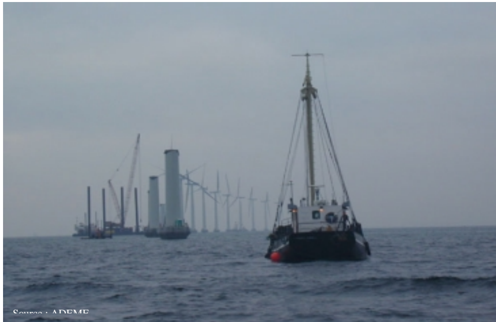
Parc de Middelgrunden au Danemark, en cours de montage ( photo : ADEME)
