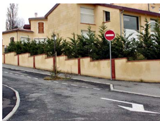
Un mur plein
