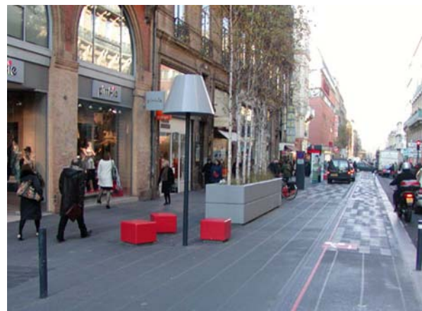
Rue d'Alsace Lorraine - Aménagement actuel
