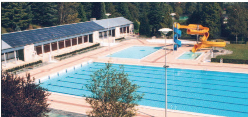
Piscine de Montmélian, panneaux solaires photovoltaïque.
