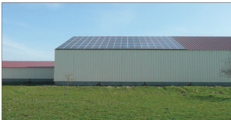
Installation photovoltaïque sur un bâtiment agricole.
