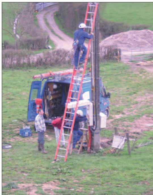
SYDESL. Intervention sur le réseau de distribution d'énergie
