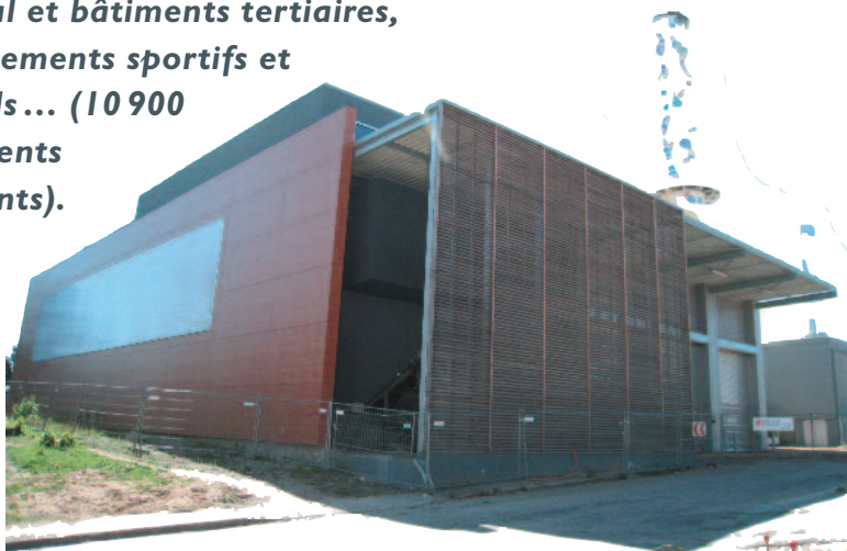
Chaufferie bois d'Épinal.
