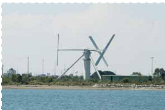
à l'échelle 1/10<sup>e</sup> a été créé dans le Pas-de-Calais. Aujourd'hui, le prototype à terre de 2 MW en vraie grandeur est testé à Fos-sur-Mer ; en 2016, l'expérimentation se fera en mode flottant. À terme, un parc de 13 éoliennes pourrait être installé au large de Fos-sur-Mer qui permettrait d'assurer la consommation hors chauffage de 30 000 foyers.
